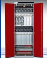
Niederspannungsschaltanlage Typ GNS-KVS
